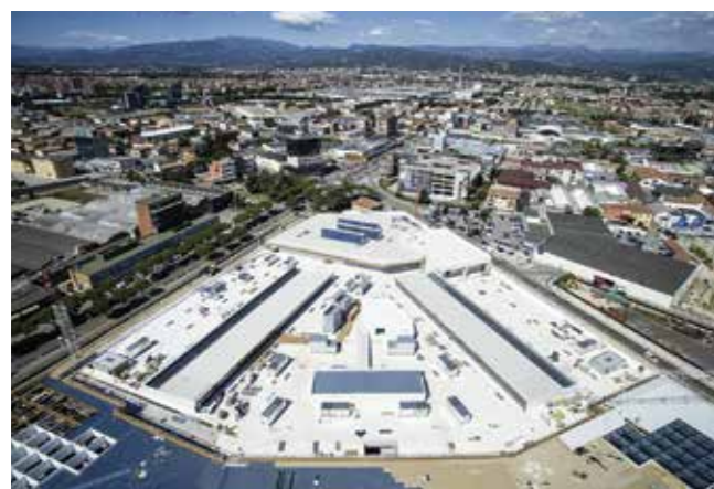
Rysunek 13: Przykładowa instalacja na obiekcie rozrywkowym ©MEHITS
